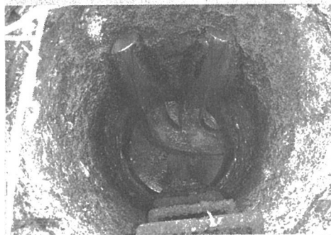
写真-1 施工前状況
