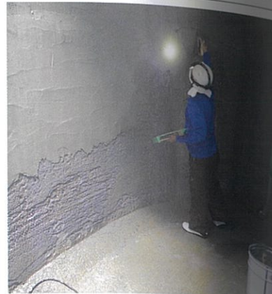
ZモルタルS-1 塗布状況
