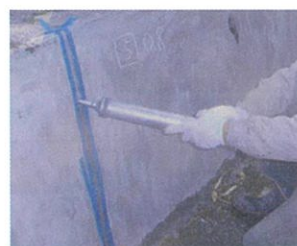
目地への施工状況
