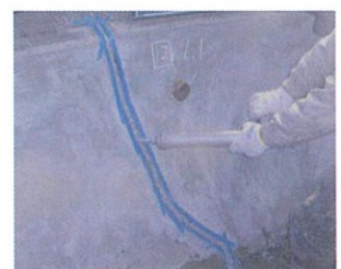
ひび割れへの施工状況
