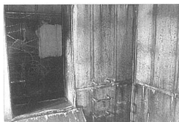
写真2 特殊マンホール調査時状況
