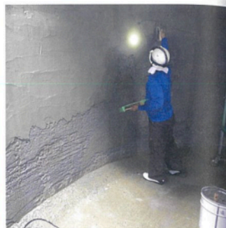
ZモルタルS-1塗布状況
