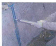
目地への施工状況
