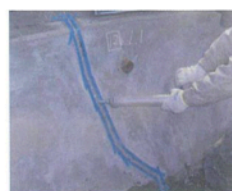
ひび割れへの施工状況
